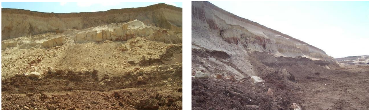
Рисунок 7 — Обрушения пород вскрыши на передовом уступе
